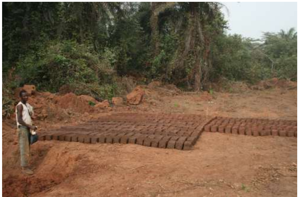
Lerblick håller på att tillverkas av jordlager + vatten..
