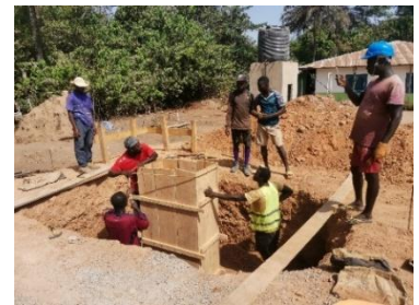
Gjutning av stolpar
